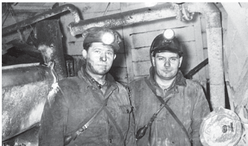
1967 год. Горняки «Томусинской» устанавливают рекорды
