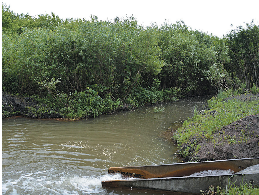
Очищенные стоки по трубопроводу через камеру смешения направляются в точку сброса на реке
